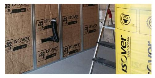
ISOLATION PAR L'INTÉRIEUR DES MURS EXTÉRIEUR ET ENTRE LES ÉTAGES ET RÉUTILISATION DU CONDUIT DE L'ANCIEN FOYER POUR UN POÊLE À GRANULÉS.
